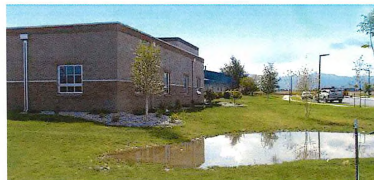
Exemple de bassin de gestion des eaux pluviales non clos, végétalisé et de pente 1 pour 6.
