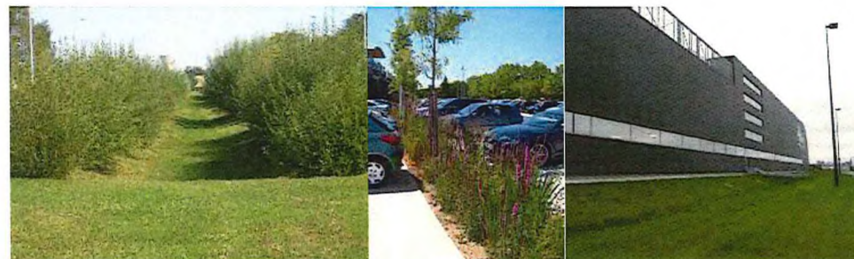
Exemples d'aménagements de gestion des eaux pluviales par noues
